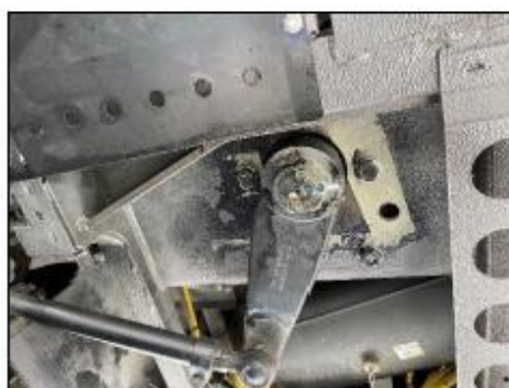
Vue de dessous du boîtier de direction présentant une fuite
